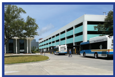
Gulfport Transit Center 1401 20th Avenue Centro de Tránsito de Gulfport Ubicado en la Calle No. 15, frente a el edificio de la Corte Federal
